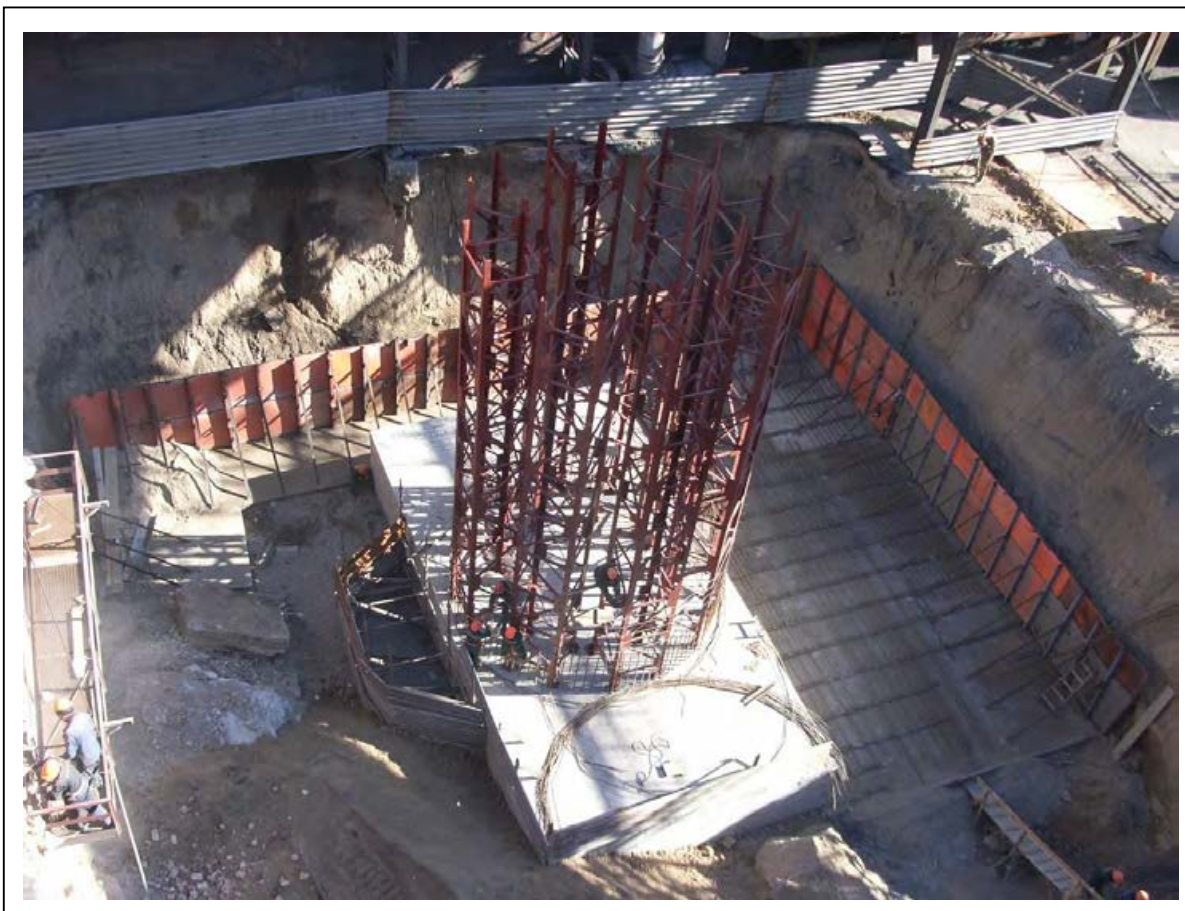
Рисунок 4: Монтаж свинцовой печи ISASMELT™ на УКМК
