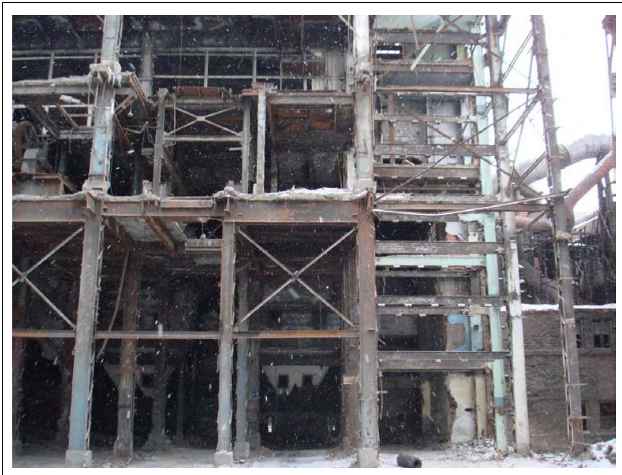
Рисунок 3: Строительная площадка Свинцового завода ISASMELT™ на УКМК
