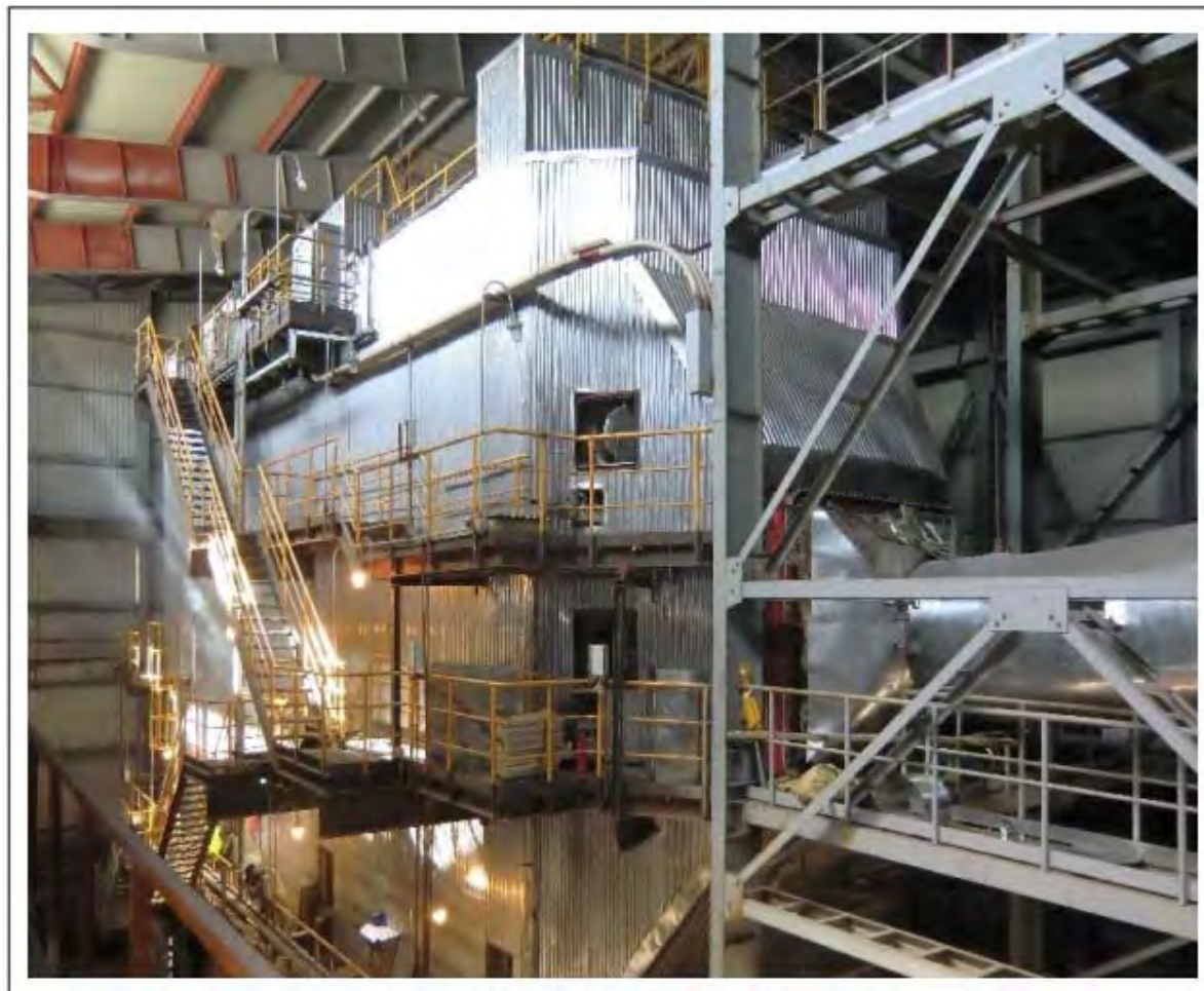
Рисунок 4: Электрофильтр на свинцовом заводе
