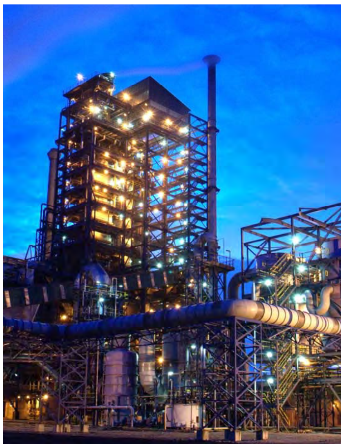
Figura 2 – Planta ISASMELT™ en la Fundición de Mufulira
