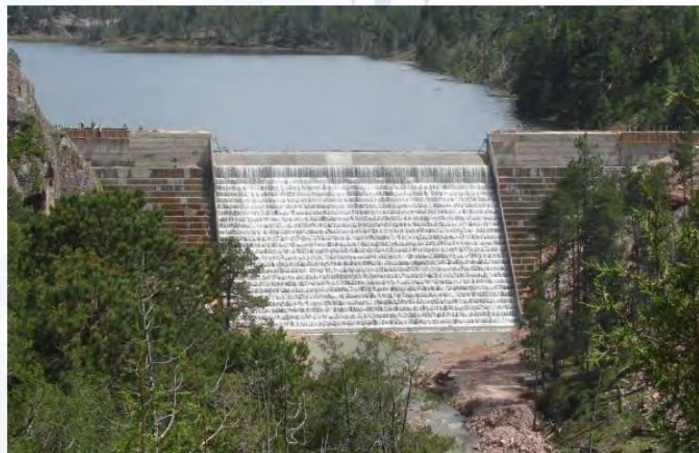
Las Truchas Hydro Electric Dam
