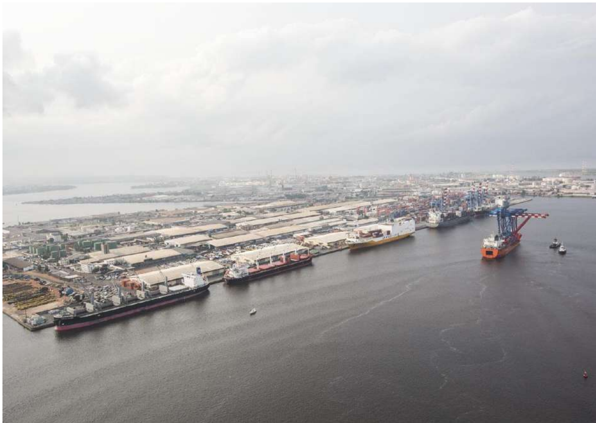
Figure 18.53: Port of Abidjan, Côte D'Ivoire
