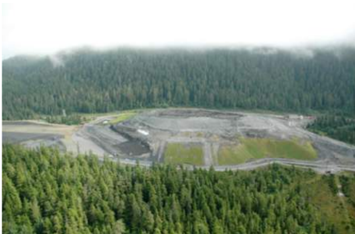
Kuva 3-12. Suodatetun rikastushiekan varastointialue Greens Creek – Kanada (Hecla Mining Company) (lähde: SRK Consulting Ltd., Rikastushiekka-alueiden sijoitusvaihtoehdot ja valintakriteerit).
