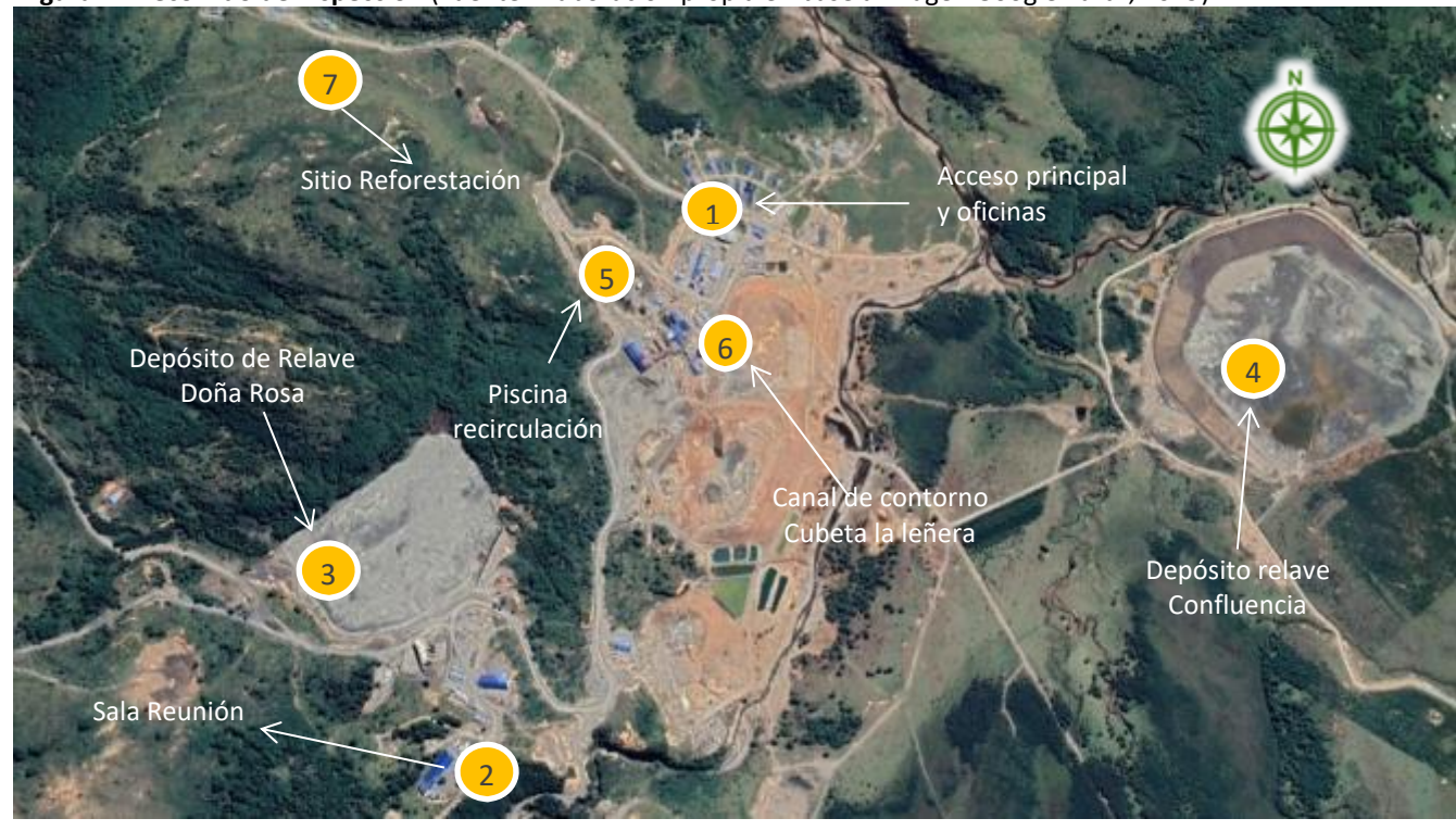
Figura 4. Recorrido de inspección (Fuente: Elaboración propia en base a imagen Google Earth, 2019)
