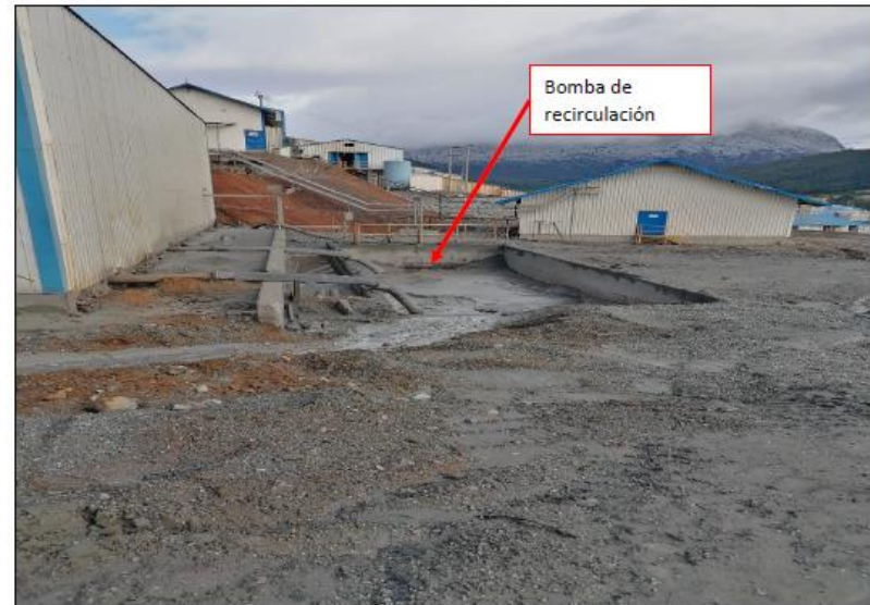
Imagen 2. Piscina de emergencia donde se reciben aguas de escorrentía.
