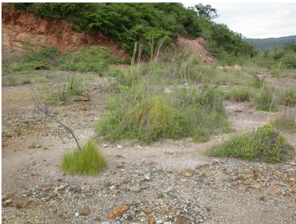
Figura 13. Estado actual de la presa de jales; al cese de actividades fue cubierta con tepetate y se llevó a cabo forestación y pastización. Dada la condición particular del sustrato se considera exitosa la restitución
