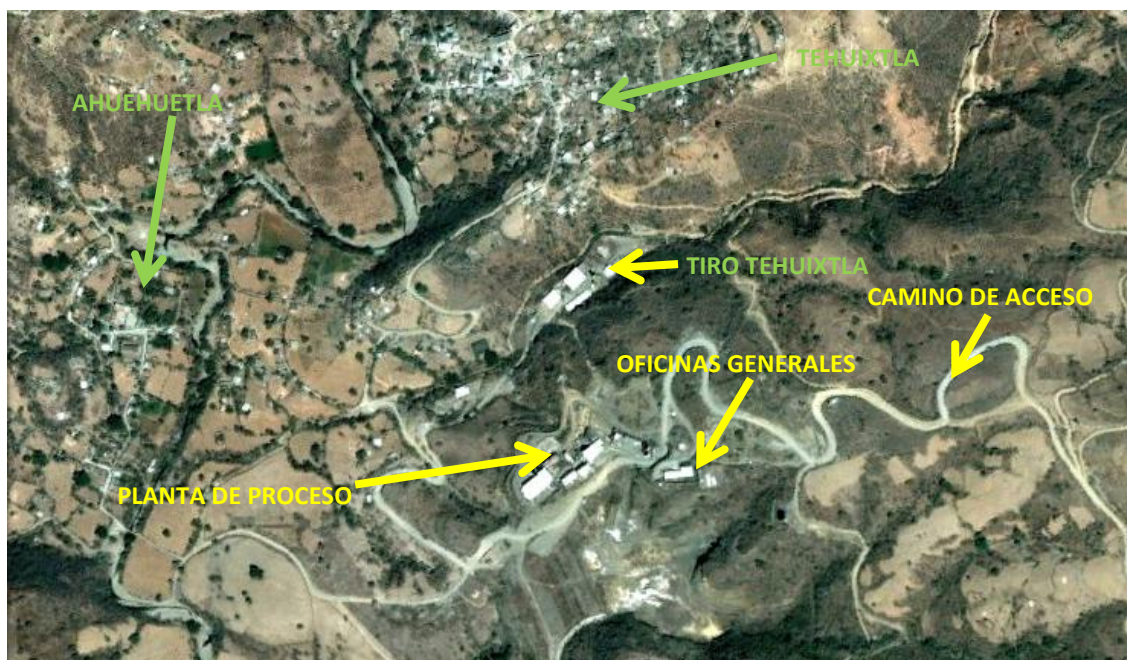
Figura 1.- Instalaciones autorizadas en 1999
