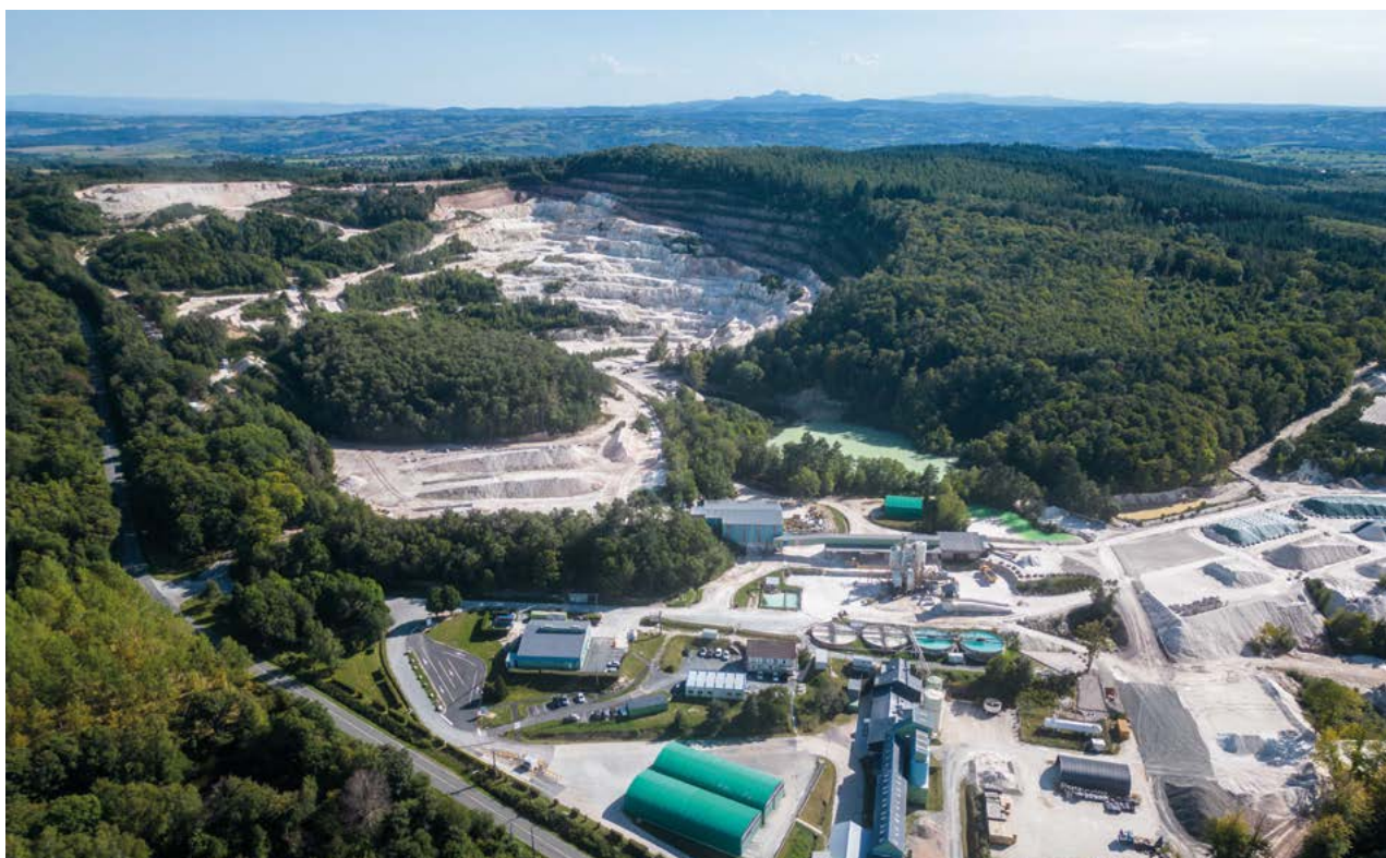
FIG. 23 - PHOTOGRAPHIE AÉRIENNE DU SITE DE LA CARRIÈRE DES KAOLINS DE BEAUVOIR AUJOURD'HUI (VUE DEPUIS LE NORD)
