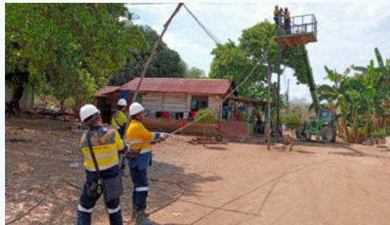
▲ Pemeliharaan generator listrik untuk desa sekitar tambang di Wetar Maintenance of electricity generators for villages around Wetar mine
