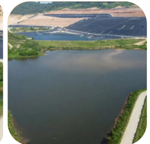
▲ Dam 4 BSI untuk menampung air hujan dari area heapleach BSI's dam 4 to collect rainwater from heapleach area
