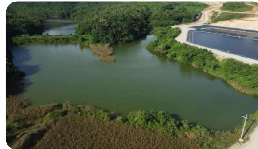
▲ Dam 5 dan 6 BSI untuk menampung air baku dan mengendapkan sedimen dalam air hujan BSI's dam 5 and 6 to collect raw water and precipitate sediment in rainwater
