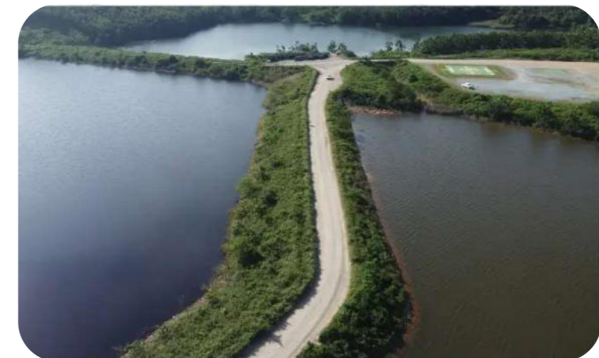
▲ Dam 1, 2 dan 3 BSI sebagai dam pengendalian lingkungan BSI's dam 1, 2 and 3 as environmental control dams
