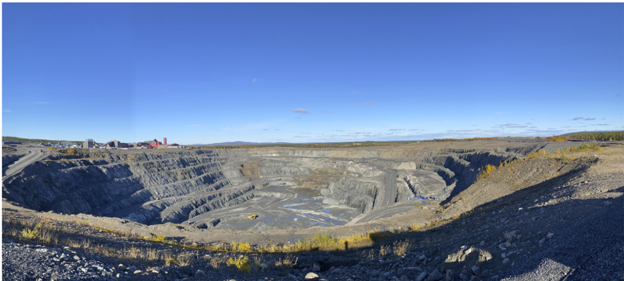
View of the Leveäniemi Open Pit at Svappavaara Mine
