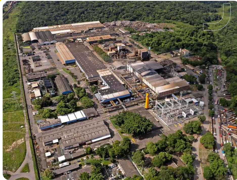
Açonorte mill, Recife (PE)
