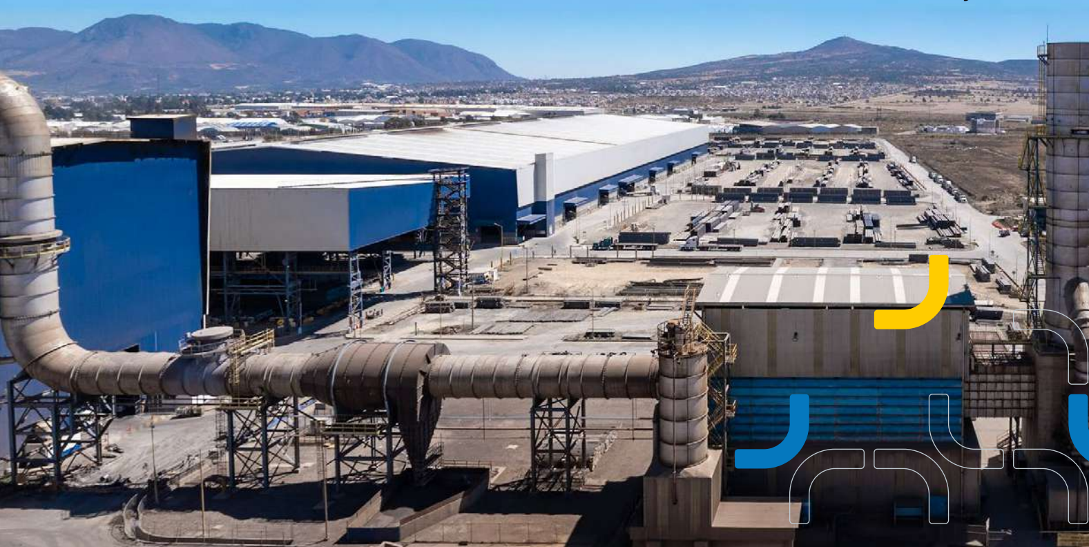
Sahagún mill, Mexico
